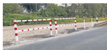
Die Zufahrt zur Fläche ist jetzt gesperrt.
